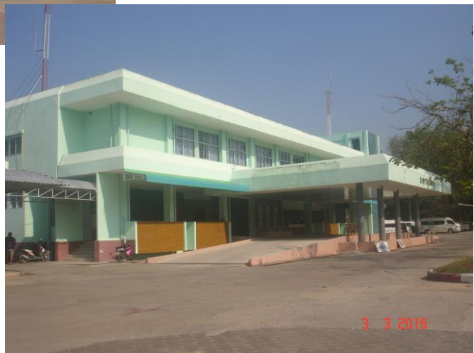
อาคารอุบัติเหตุ
